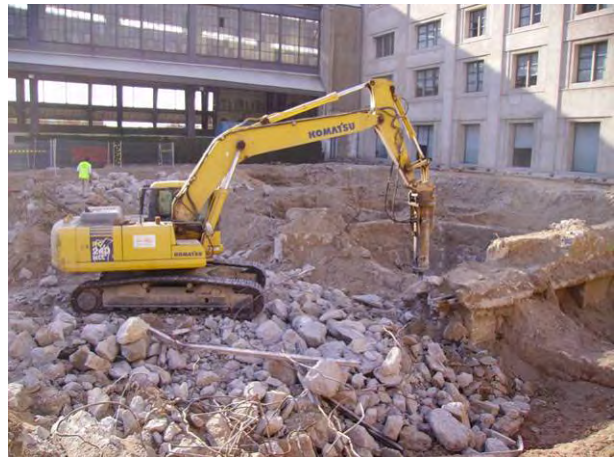
FOTO 4. Màquina giratòria amb martell hidràulic demolint el formigó
