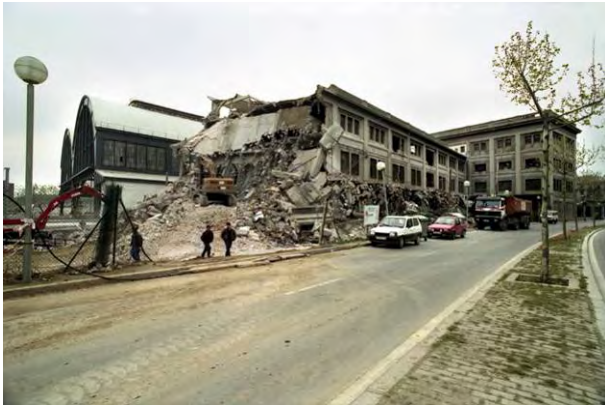
FOTO 1. Enderrocament de l'edifici a l'any 1992
