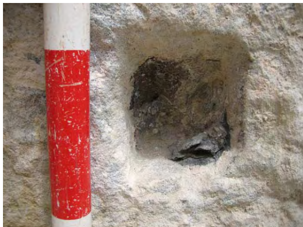
FOTO 17. Detall de la UE 242, molt probablement plom amb la funció de fixar o ajustar el ferro d'una hipotètica reixa en l'encaix UE 238
