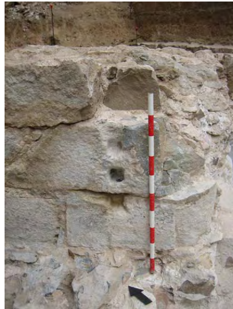
FOTO 16. Detall dels encaixos UE 237, 238 i 239 i de la pedra arrodonida del reforç extern de la muralla UE 167
