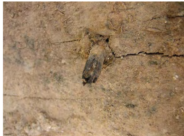
FOTO 8. Detall d'un clau de forja a la fusta UE 229 de l'encofrat del segle XVI
