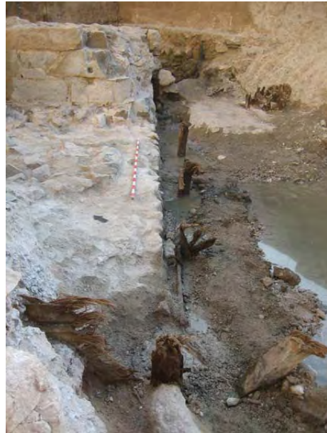
FOTO 6. Estaques i taulons UE 229 de l'encofrat del segle XVI per a la construcció de la base del Rec Comtal UE 225
