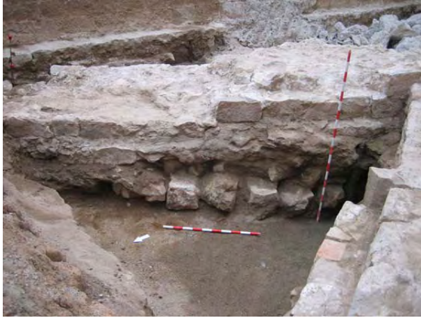
FOTO 13. Detall de l'alçat de la muralla UE 167 i la seva fonamentació UE 179 a la cara interna
