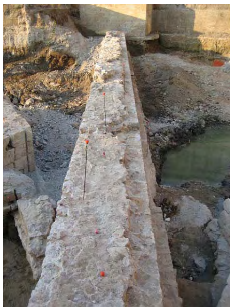
FOTO 37. Vista en què es pot observar el reblliment intern de la contraescarpa
