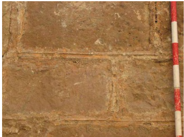
FOTO 36. Detall del parament oest de la contraescarpa, UE110. S'aprecia la coloració del morter i l'acabat en relleu de semicercle incís (mitja canya)
