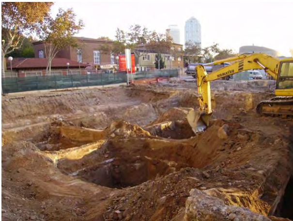
FOTO 3. Màquina giratòria excavant
