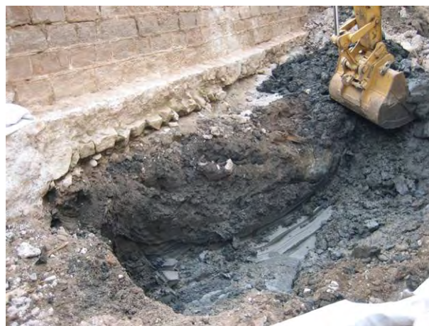
FOTO 22. Sondeig 12 entre la contraescarpa (UE 110) i la base del Rec (UE 225)
