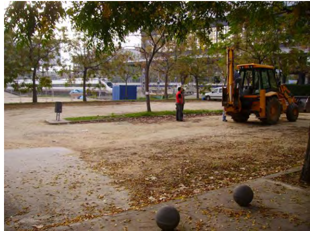
FOTO 2. Solar abans de l'inici dels treballs
