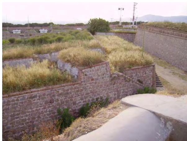
FOTO 32. Exemple de contraescarpa i de camí cobert del castell de Montjuïc
