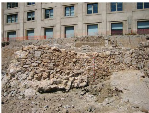
FOTO 27. Detall de l'estructura en forma de "V" (UE 112 i 208)
