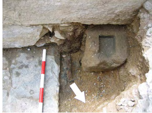
FOTO 14. Detall de la fusta UE 228 de l'encofrat del segle XVI per a la construcció de la base del Rec Comtal, UE 225, i encaix UE 241, probablement per a una reixa
