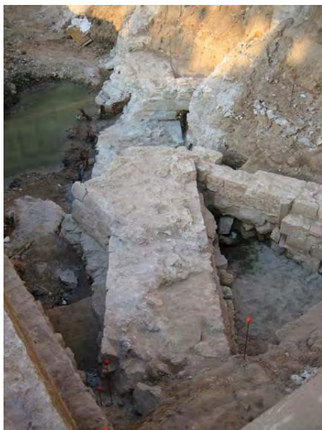
FOTO 9. Muralla del segle XVI. En primer terme, tram UE 167, i, al fons, tram UE 176. A la banda superior dreta mur UE 166 i 199 del Rec Comtal
